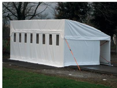
Des exemples de pas de tir couverts fermés peu onéreux, ont été réalisés avec des matériaux et des structures légères, à partir de produits industrialisés pouvant être notamment montés par les bénévoles. Ils peuvent aussi être pensés pour être évolutifs.
