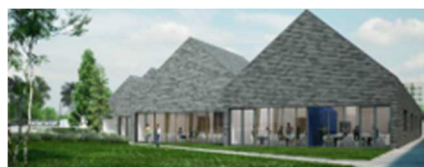
Nouveau bâtiment après reconstruction
