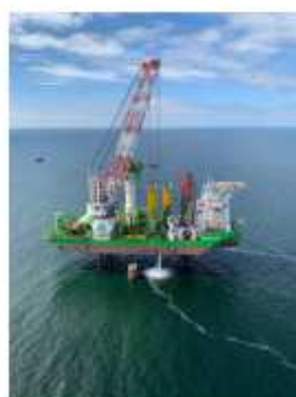
Installation par le navire « L'Innovation »
