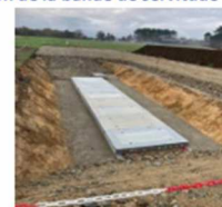
Chambre de jonction terrestre, située tous les kilomètres environ 16
