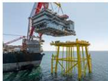
Installation de la fondation et de la sous-station
