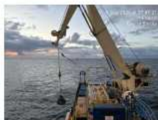
Mise en place de sac de roches
