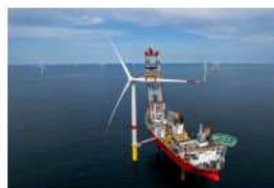
Installation de la dernière pale en C04 27/04/2025
